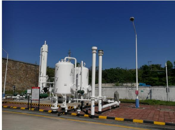
图4-6 油气回收装置
