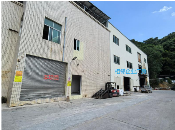
项目南面厂房现状
