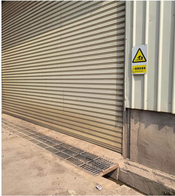
厂区排水沟及固废标识
